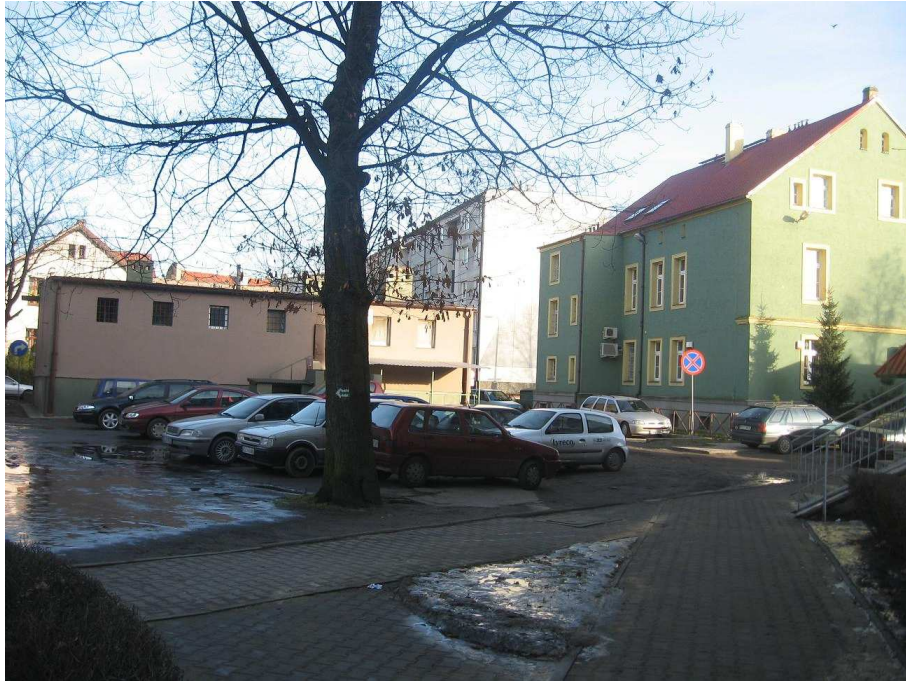
Fot. 5. Jedno z wnętrz międzyblokowych. Na zdjęciu widoczne samochody zaparkowane na zaimprovizowanym parkingu oraz zniszczona nawierzchnia.
