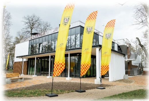
Budowa budynku inkubatora przedsiębiorczości w Parku Wrocławskim w Lubinie.
