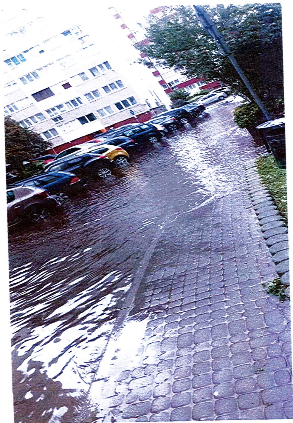
Rysunek 7. Nawierzchnia drogowa po kilku godzinach opadów w dniu 30.06.2025 r. ulica Kazimierza Wielkiego w pobliżu skanalizowanej Zimnicy. Materiały od mieszkańców
