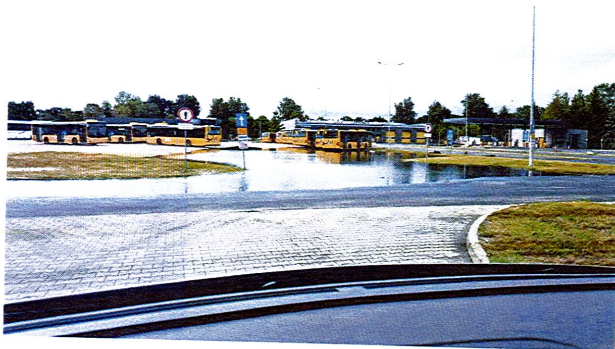
Rysunek 5. Nawierzchnia drogowa po kilku godzinach opadów w dniu 30.08.2025 r., okolice placu manewrowego PKS Lubin.
