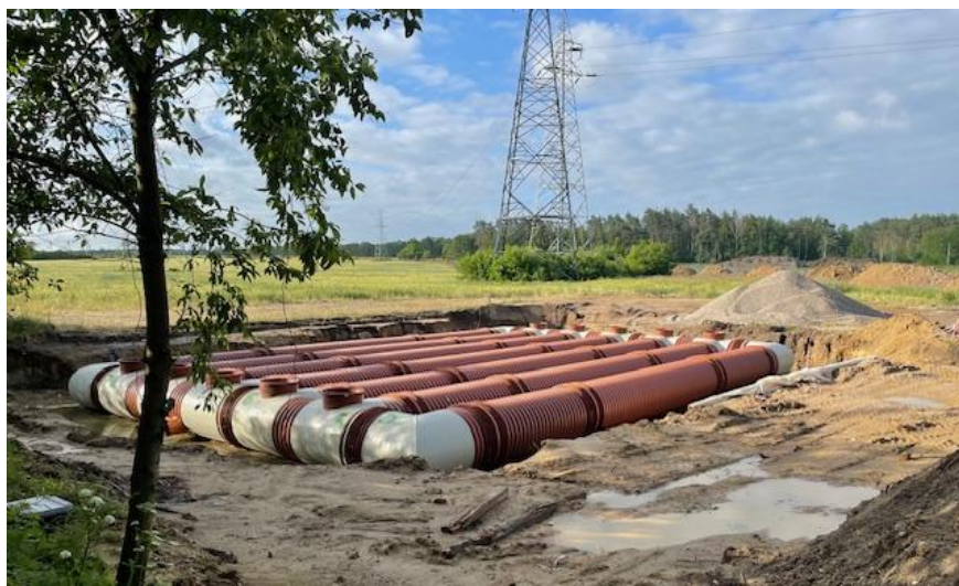
Rysunek 6.3 Podziemne zbiorniki retencyjne przy ul. Niedźwiedziej [UM]
